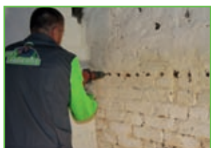
Wiercenie otworów w poziomie
