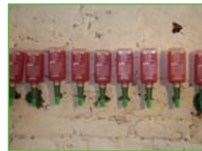
Rozchodzenie płynu iniekcyjnego w ścianie
