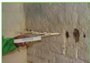
Osadzenie wałków dozujących KÖSTER Kapillarstabchen
