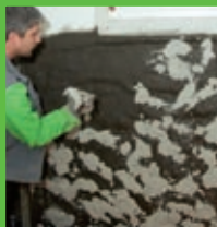
Nakładanie obrutki renowacyjnej
