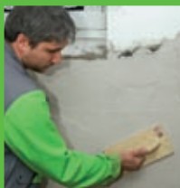
Wygładzanie powierzchni
