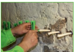
Montaż uchwytnów pod kartusze KÖSTER Saugwinkel
