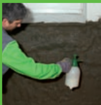
Gruntowanie KÖSTER Polysil® TG 500
