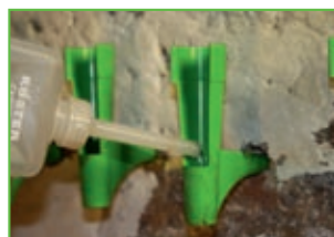
Zmoczenie wałków dozujących, aby spęczyły w otworach
