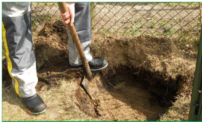
1. Wykopujemy dołek o głębokości 30-40 cm.
